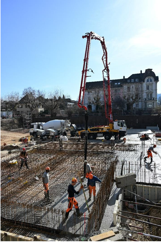
Bétonnage 1 ère étape radier salle de sport
