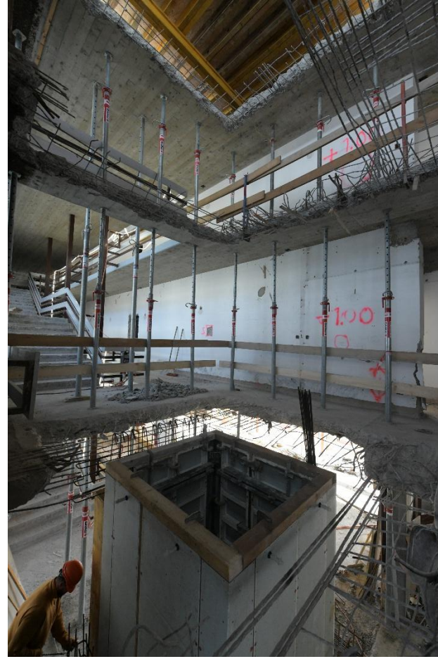
Intégration cage d'ascenseur dans le collège
